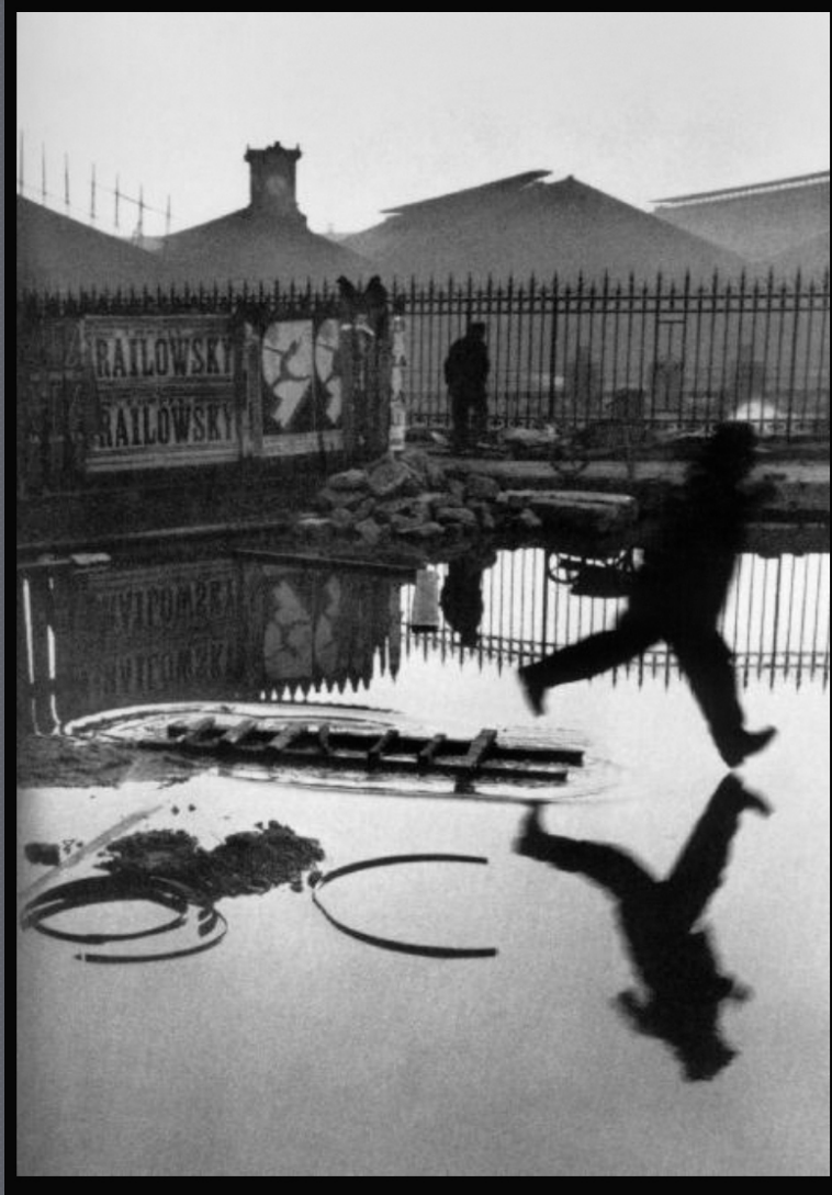
Henri CARTIER-BRESSON, Derrière la gare Saint-Lazare, 1932
